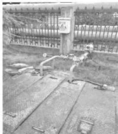
废水排口及监测池
