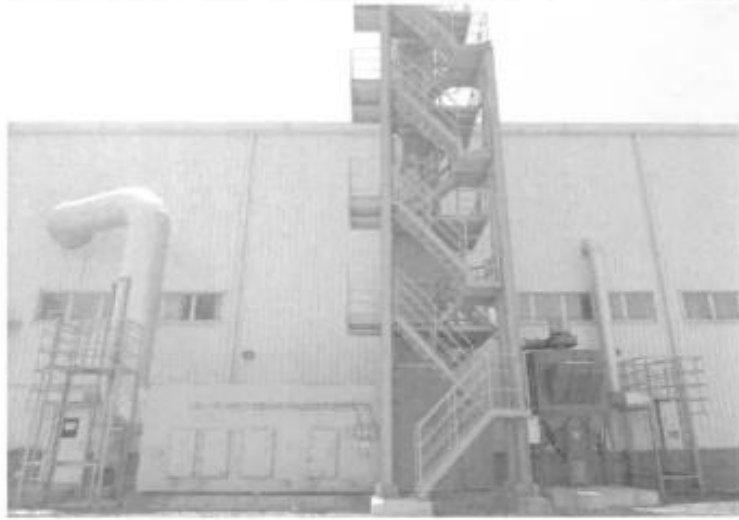
多层功能复合膜生产车间油分吸附分离器
