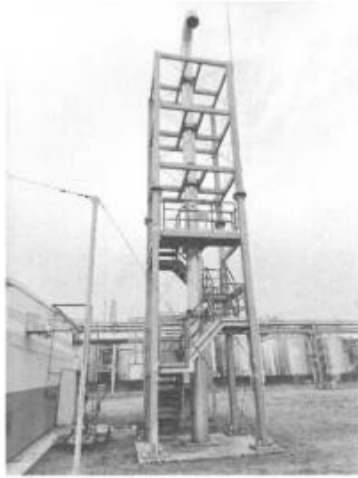
实验室有机废气处理设施
